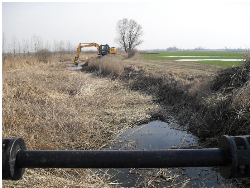
6-os kép: Növényzettel erősen benőtt csatorna kotrása, a hínárvágók által kivágott uszadék kiszedése
