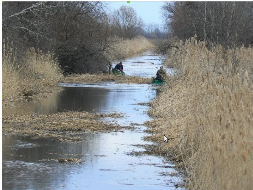
5-ös kép: Hínár és nádvágás, belvíz elvezetés javításáért
